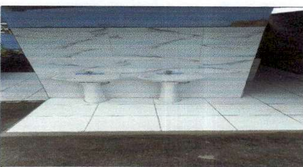
Foto 6: Colocación de lavamanos y azulejo
