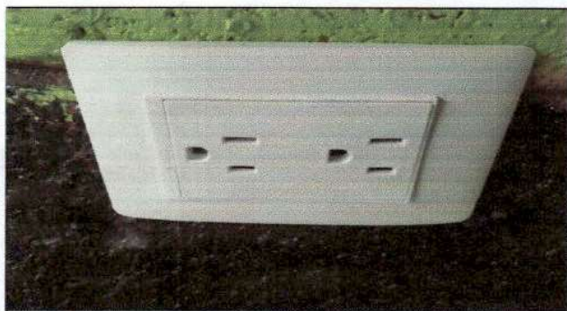
Foto 3: Reparación del sistema eléctrico
