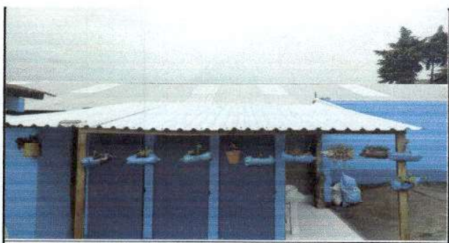
Foto 5: Cambio de lámina y puertas de los baños
