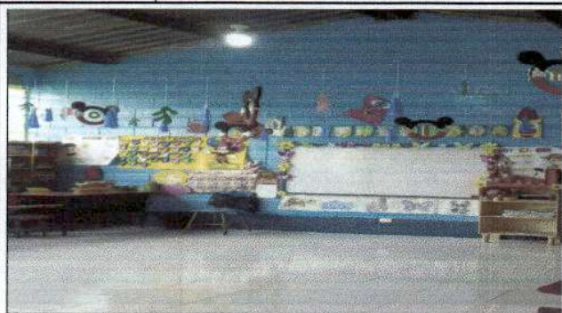
Foto1: Cambio de piso cerámico y pintura de paredes
